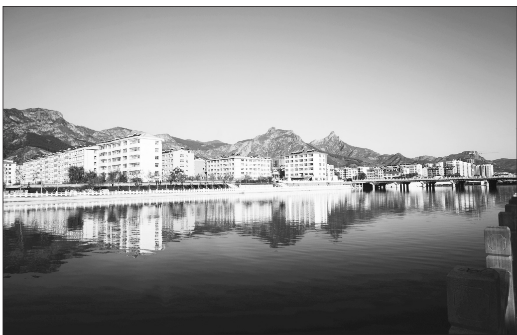
图为伊逊河环境综合整治工程县城段。
