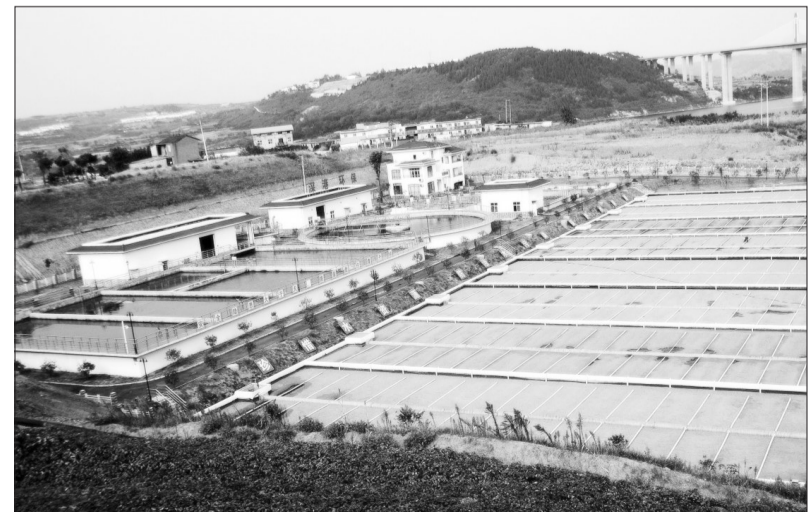
作为南水北调中线工程核心水源区,湖北省十堰市郧阳区加强污染源监管,加快环境基础设施建设,全区城乡23座污水处理厂33座村级污水处理站全天候投入运行,确保一库清水永续北送。图为长岭污水处理厂的设备在工人的操作下有序回收污水,经再处理,检测合格后才排出厂外。
