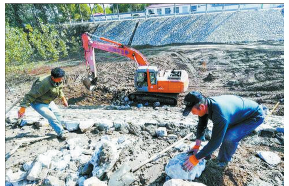
河北省霸州市对农村垃圾坑、污水坑采取加固、回填等措施进行治理和改造,建成一批生态游园、水上乐园,改变了脏乱差的旧貌。 李晚果/摄 新华社供图
