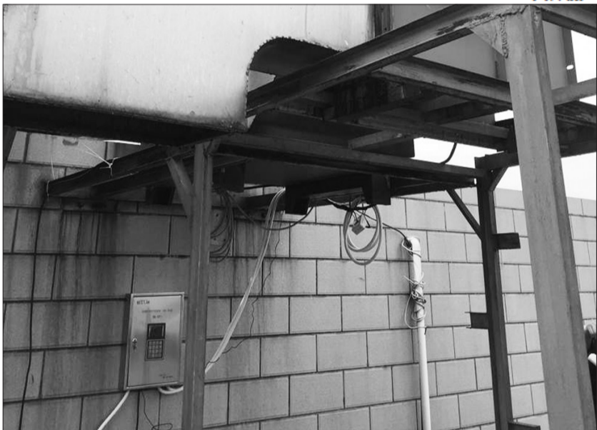
安装在天心区政府机关食堂烟道的白色探头,可对油烟排放浓度、清洁度和仪器开关状态等情况进行监控。文萍摄
