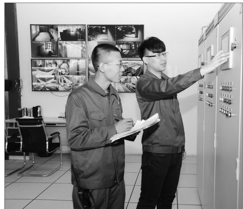
新疆维吾尔自治区昌吉市今年关停西部热力、庆源热力等4家供热企业燃煤锅炉后,为切实做好供热保障工作,积极推动“煤改气”供热工程,投资2.85亿元,新建两座天然气供热站,扩建天然气门站及天然气管网。两座燃气供热站作为热源厂及兴隆热力的替代热源,可替代供热700万平方米。图为供热站控制室。本报记者贾恒恒摄
