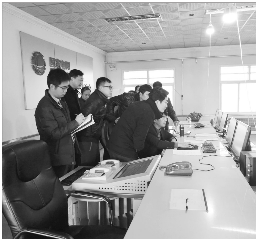
督查组在博野县供电公司通过智能电网调度控制系统查看用电负荷数据。刘星摄
