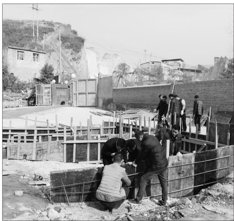
图为工人正在建设污水收集二级沉淀池。 叶相成/供图
