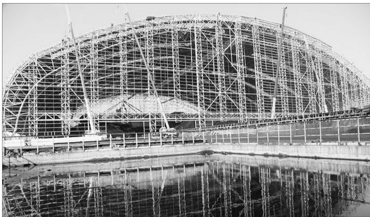
内蒙古自治区包头市投资1.2亿元建设的华电包头发电公司储煤仓工程进入尾声。此项目跨度达197米,为亚洲目前跨度最大的储煤仓,可存煤19万吨,建成后每年可减少1.1万吨煤尘污染,将对改善周边环境质量,推进包头市大气污染防治起到积极作用。图为正在建设中的华电包头发电公司储煤仓。 李俊伟 刘清成摄
