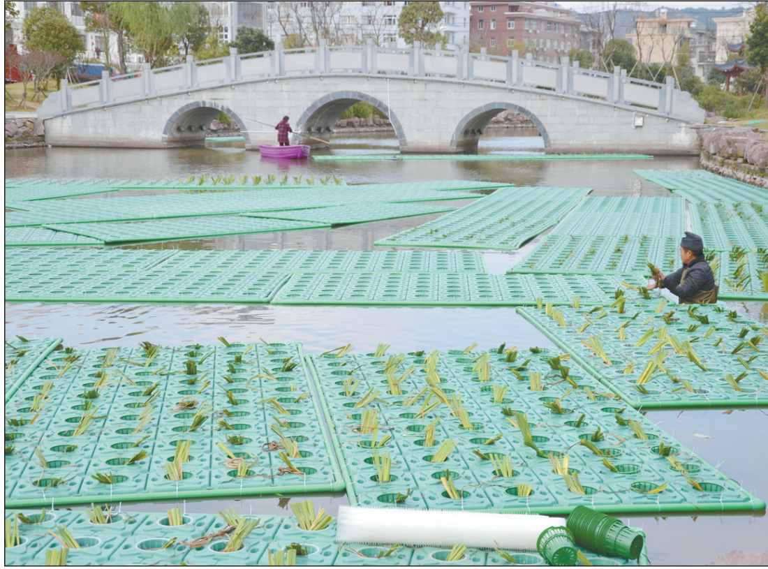
12月28日，浙江省玉环县龙溪镇新港河面上，河道环卫工人在摆放塑料板搭建的“浮床”，点播泥土陶粒，栽种黄鳝蒲、鳊尾等水生植物，“吃”掉水中富营养物质和污染物，洁净溪水，美化河道。詹智摄/人民图片网供图
