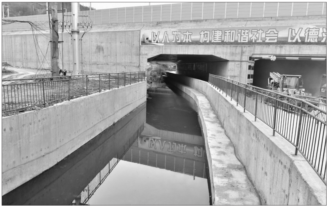
四川省广元市自去年启动城市黑臭水体综合整治工程以来,目前已完成5条黑臭水体的治理。图为整治后的韩家沟。
