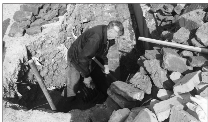
顺藤摸瓜找到排污口后,经连接、固定PE管道,顺利将污水接入市政管网。
