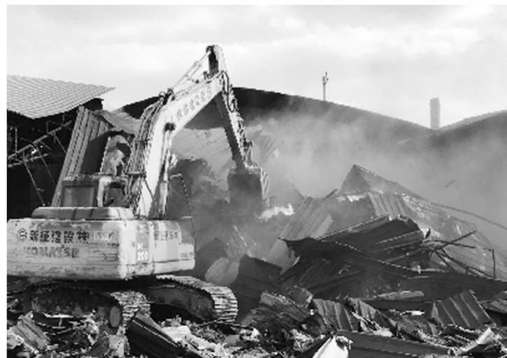
大荆镇拆除85家铸造企业厂房,彻底淘汰了当地的支柱产业。图为拆除现场。
