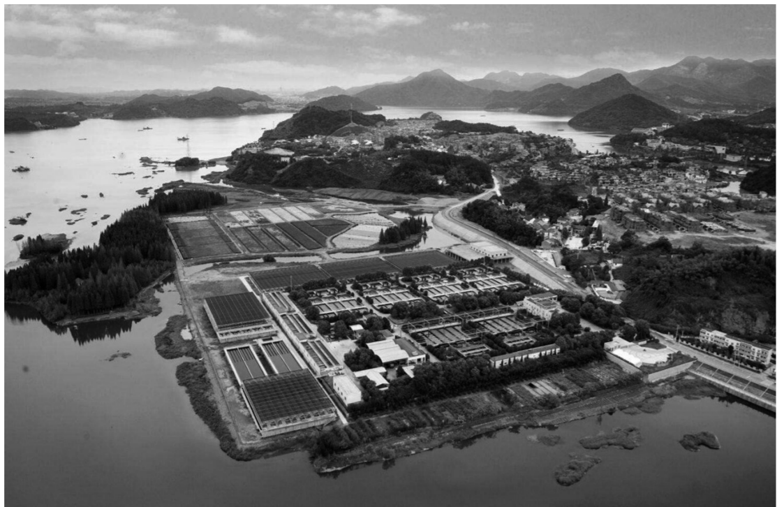
图为浙江省临安市污水处理厂
