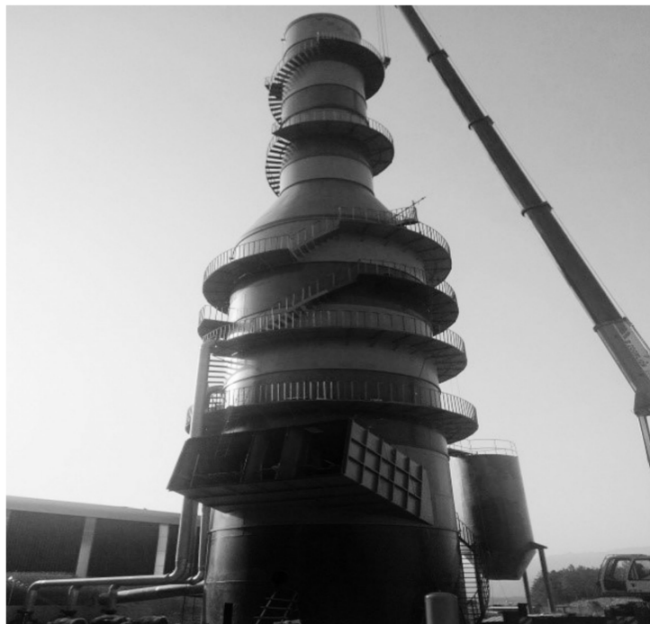
图为湖北亚细亚陶瓷有限公司建设中的“环保塔”,将用于集中处理窑炉尾气和喷窑干燥废气,可去除废气中的二氧化碳、颗粒物等多种污染物,预计3月底建成投用。陈雄摄
