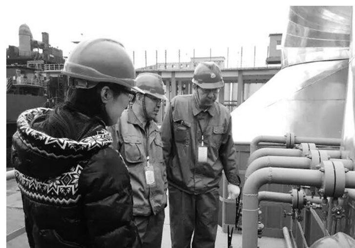
图为技术工程师现场调试工艺设备。
