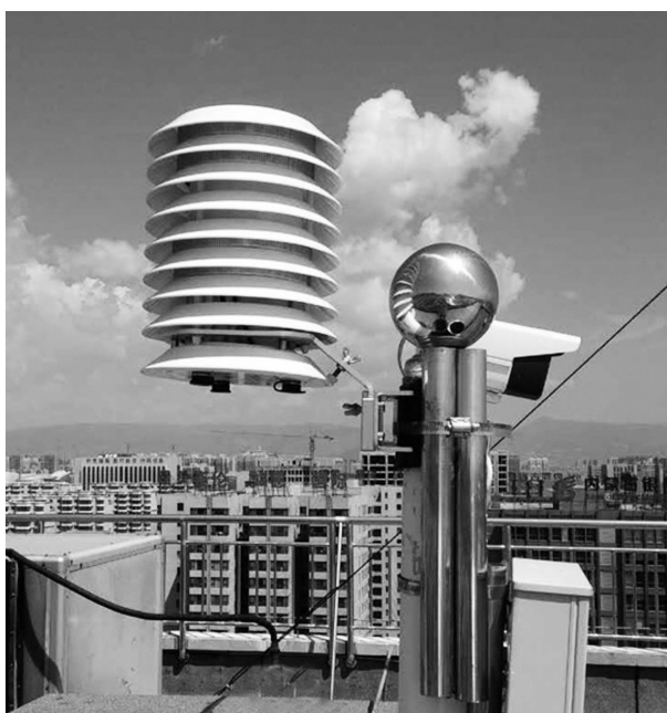
图为空气传感器现场安装图。
