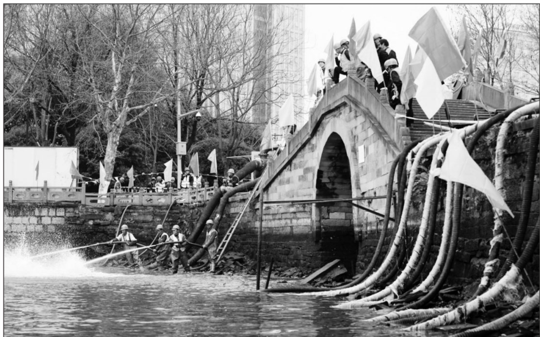
浙江省首个湖泊治理PPP项目——宁波市海曙区月湖水生态治理工程近日正式启动。海曙区引入PPP模式,通过公开竞争,中标企业将对月湖实施清淤及淤泥处置、水质提升与水生态构建、绿化提升、海绵体修复及智能化管理等五大工程。
