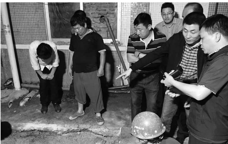
图为深圳市执法人员深夜开挖永利鑫五金制品有限公司地面,检查是否私设暗管偷排废水。 深圳市环保局供图
