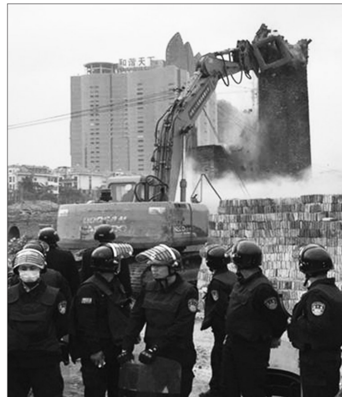
为淘汰落后产能、实现绿色发展,彻底解决污染扰民问题,厦门市同安区近期开展了“三厂”(机砖厂、水泥厂、饲料厂)整治专项行动。经过1个多月的集中整治,44家“三厂”整治对象已经全部签订拆除协议,已停产41家,拆除19家。目前,厦门市正在继续加大力度,力争于5月1日前完成全部整治任务。图为机砖厂拆除现场。
