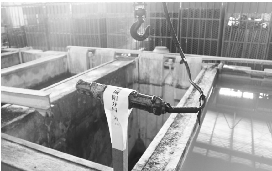
2016年12月14日上午,城阳分局对钰源公司造成污染物排放的两台行车、两个配电箱、6个酸洗磷化池进行了原地查封。 青岛市环保局城阳分局供图
