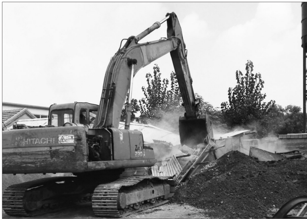
山东省枣庄市环保部门日前组织人员对辖区内燃煤小锅炉及“小散乱污”企业开展全面排查。图为枣庄市高新区组织力量现场拆除排查发现的违规小石料粉碎厂。
