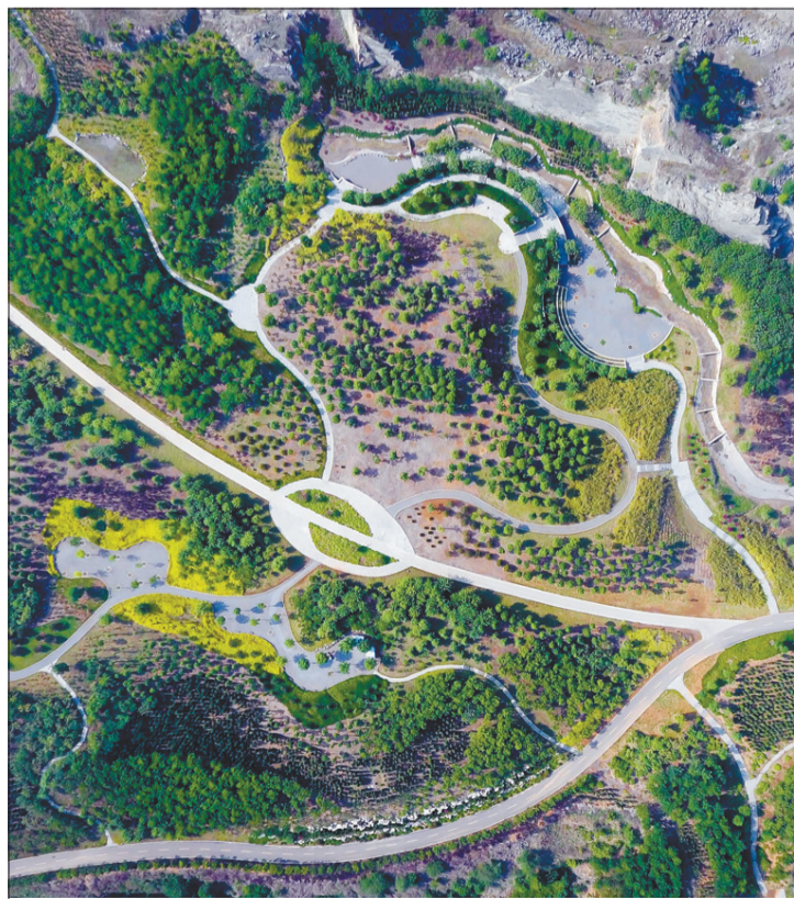
山东省济南市卧牛山由于长期过度开采,一度严重破坏。2013年,济南市对全面禁采后的卧牛山启动生态修复和地质公园建设工程,曾经满目疮痍的山体如今已被苗木花卉覆盖。新华社供图
