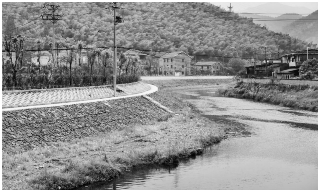
图为富阳大源溪整治后的河道环境。
