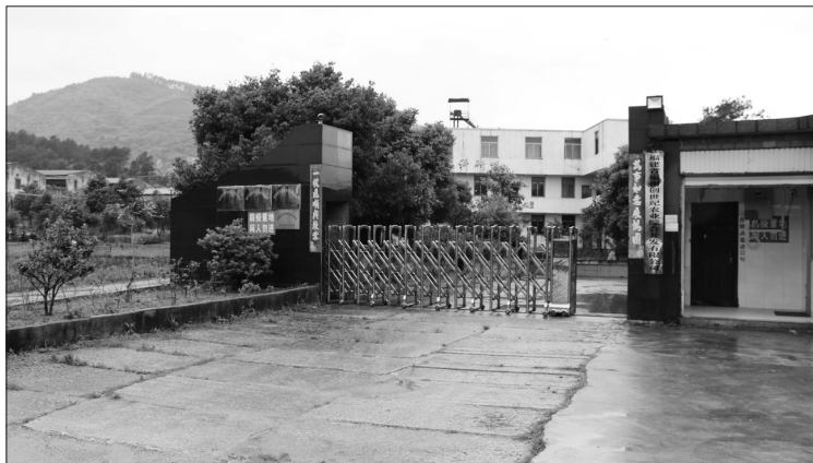
福州创世纪农业综合开发有限公司在未经林业主管部门审批的情况下,擅自在林地上修建办公楼及养猪场棚等建筑物,占用并造成71.8亩林地被严重毁坏,无法恢复。
