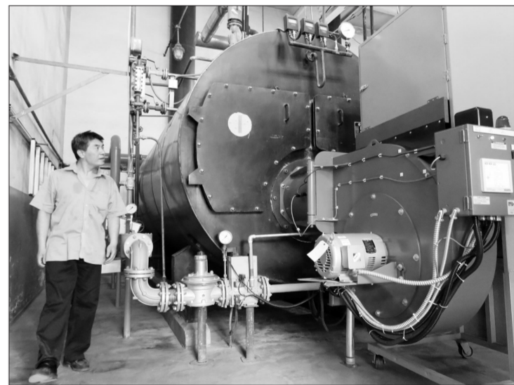
从2016年开始,北京市在全国率先开展燃气锅炉低氮改造。为促进锅炉改造工作,北京市环保局、财政局、质量技术监督局联合发布《北京市燃气(油)锅炉低氮改造以奖代补资金管理暂行办法》,对燃气(油)锅炉低氮改造项目进行补贴。图为北京乐游饭店投资60余万元对燃气锅炉进行低氮改造。 本报记者邓佳摄
