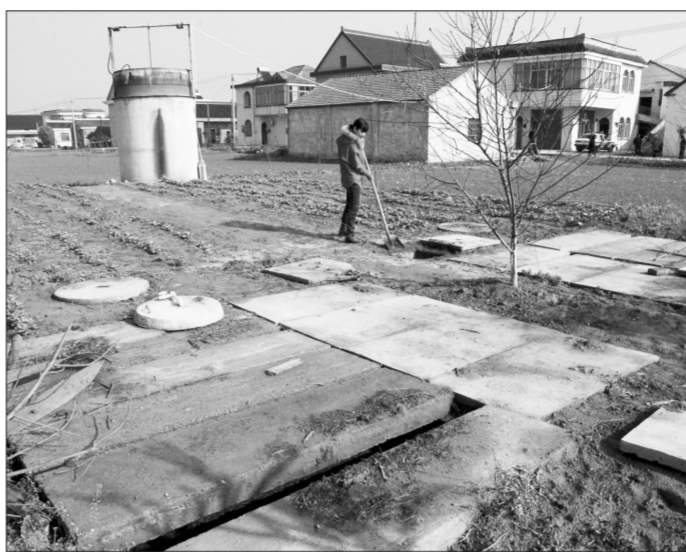
▲图为李小燕家的猪粪沼气池和储气罐一角。 仇稳山 金华摄
