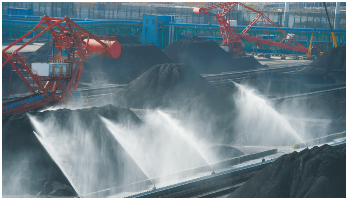
神华黄骅港煤炭露天堆场正在实施洒水抑尘作业。
