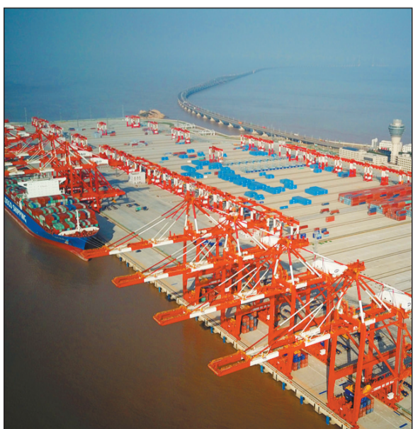
全球最大的集装箱全自动化码头“上海国际航运中心洋山深水港区四期工程”,计划在12月10日开港试运营。工程最大特点是实现了码头装卸等环节的全过程智能化、无人化操作,对提高作业效率与安全性、环保性都具有重要意义。
