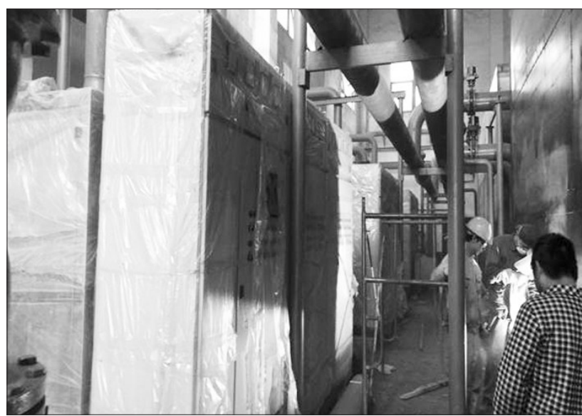
江苏省连云港市东盛四季花城小区集中供暖“煤改电”项目日前投入使用,该项目是江苏省首个在居民小区实施的集中供暖热源电能替代项目。改造后,预计年替代电量510万千瓦时,节约燃煤约2418吨,减少二氧化碳排放约8866吨。图为工作人员正在安装调试。 韩东良 肖桥 王从帅摄
