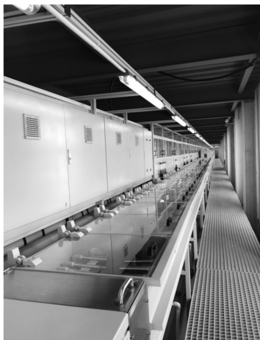
图为庆泰电镀企业改造后的电镀生产线。王璐摄
