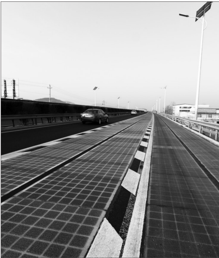
世界首条高速公路光伏路面试验段日前在山东省济南市绕城高速公路南线正式通车。该试验段全长1120米,光伏路面铺设长度1080米,预计年发电量约100万千瓦时。试验路段目前已具备为高速公路路灯、电子情报板、融雪剂自动喷淋设施、隧道及收费站提供电力供应的功能。 本报记者邓佳摄
