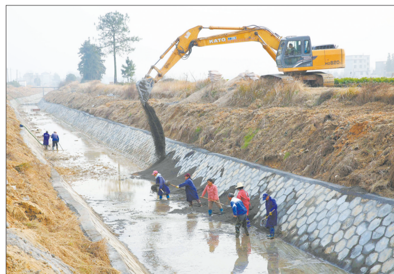
近年来,江西省永丰县结合农业产业发展、扶贫攻坚、美丽乡村建设,精准实施了一批农田灌溉排涝、农村安全饮水、水土保持生态绿化、高效节水灌溉等项目工程,助推乡村振兴战略实施。图为2月26日,在江西省永丰县恩江渠灌区,施工队伍忙着维修农业灌溉渠道。 人民图片网供图
