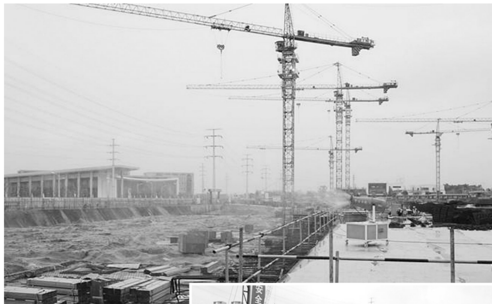
▲南京“智慧化”控尘试点工地。
