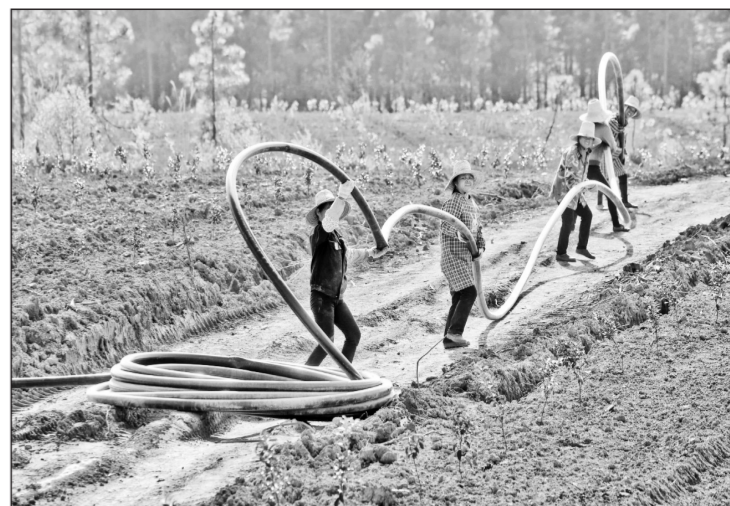
江西省永丰县近年来致力于水利扶贫工程建设，在全县1824个家庭农场推行高效节水灌溉模式。图为永丰县七都乡返乡农民工创办的家庭农场，工人在水土保持生态果园基地安装滴灌管道。 人民图片网供图
