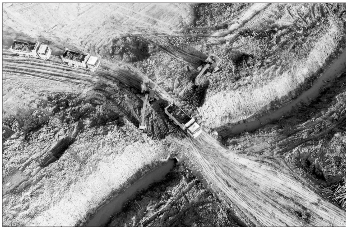
安徽省庐江县柯坦镇境内的引江济淮工程目前正在紧张施工之中。通过引江济淮和江淮沟通段的实施，既可以提升合肥市通江的航运能力，更重要的是可以增强巢湖入湖水量，提高水体自净能力，扩大湖泊环境容量，对改善巢湖水环境起到积极作用。 人民图片网供图
