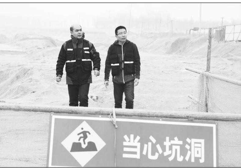
时间:2018年2月22日09:30 地点:天津市阳光乐园地铁项目施工现场
