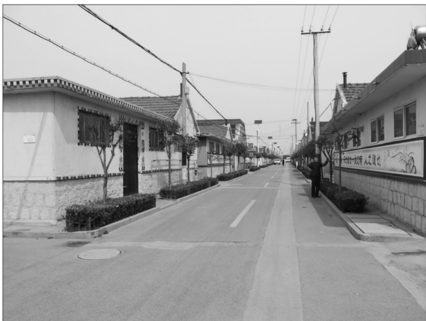
一直以来,生活污水乱排是影响农村生态环境的难题。以前,山东省胶州市纪家村民的泔水、厨余水、洗衣水等泼到路上,排到沟里,流入湾塘。去年,胶州市投资240万元,为纪家村村铺设污水管网3420米、雨水收集管网4798米,实现了雨污分流。同时,新建污水处理站1处,将村民家厕所污水通过管网接到村里污水处理厂,家庭污水通过自家化粪池过滤之后直接流进处理厂,让村里的水环境好起来。张秋营摄
