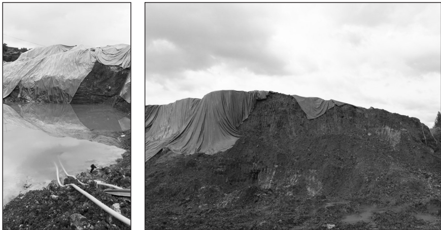
含铅废渣堆场集水严重、防渗膜破裂。
