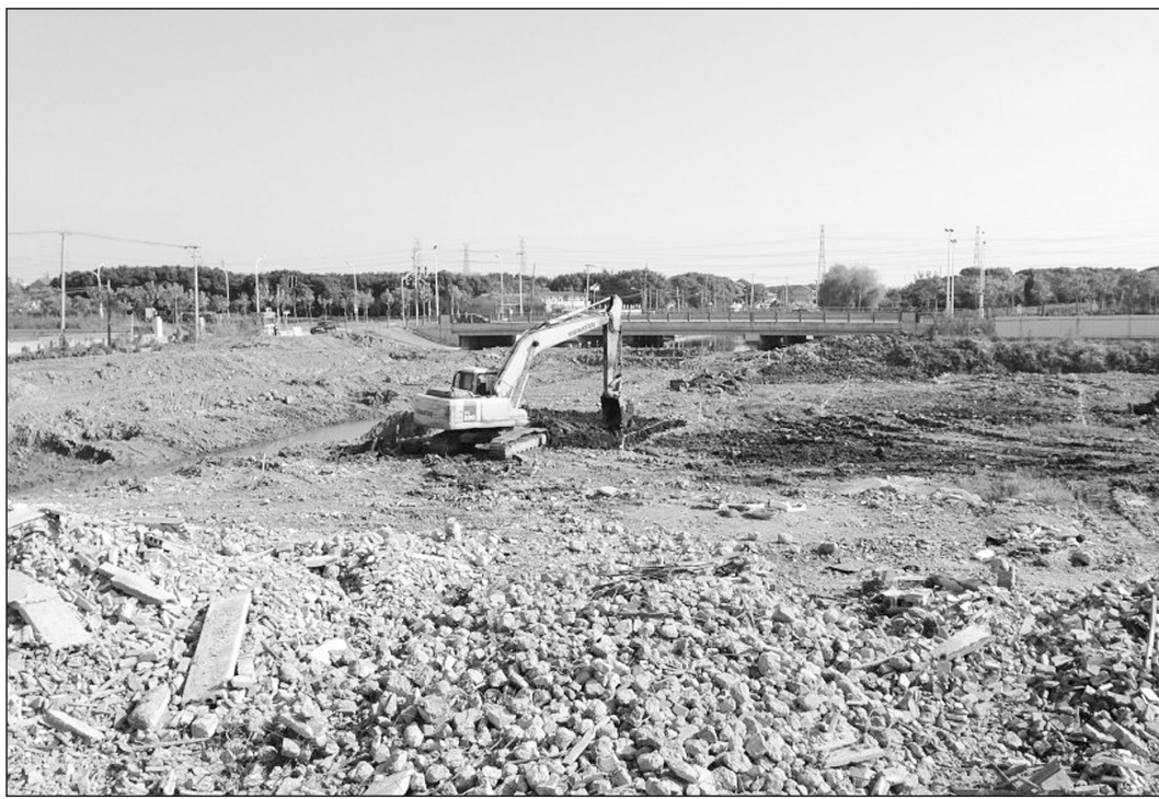
图为上海迪士尼乐园某地块曾进行的污染土壤修复工程。
