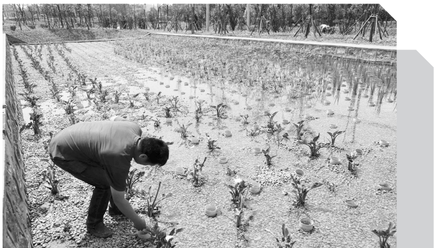
宝象河公家村排口雨污拦截调蓄池净化工程通过植物砾石等进行过滤。李海曦/摄
