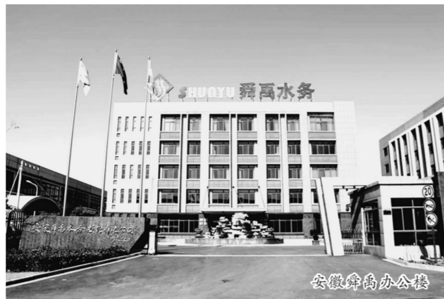
安徽舜禹水务办公楼
