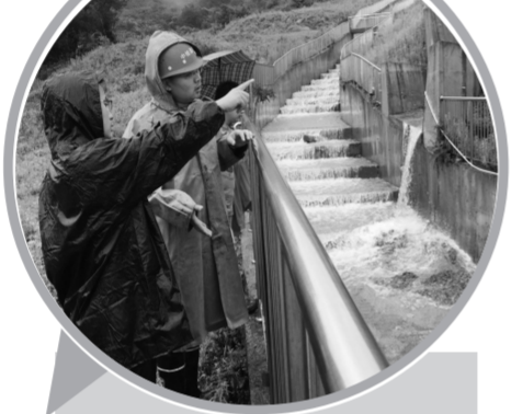
西南核安全监管站工作人员在处置场检查核设施防汛情况。孙浩摄
