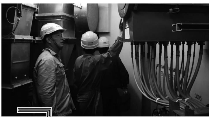
图为大亚湾核电站值班人员正在检查连接厂房的贯穿件情况。中广核供图
