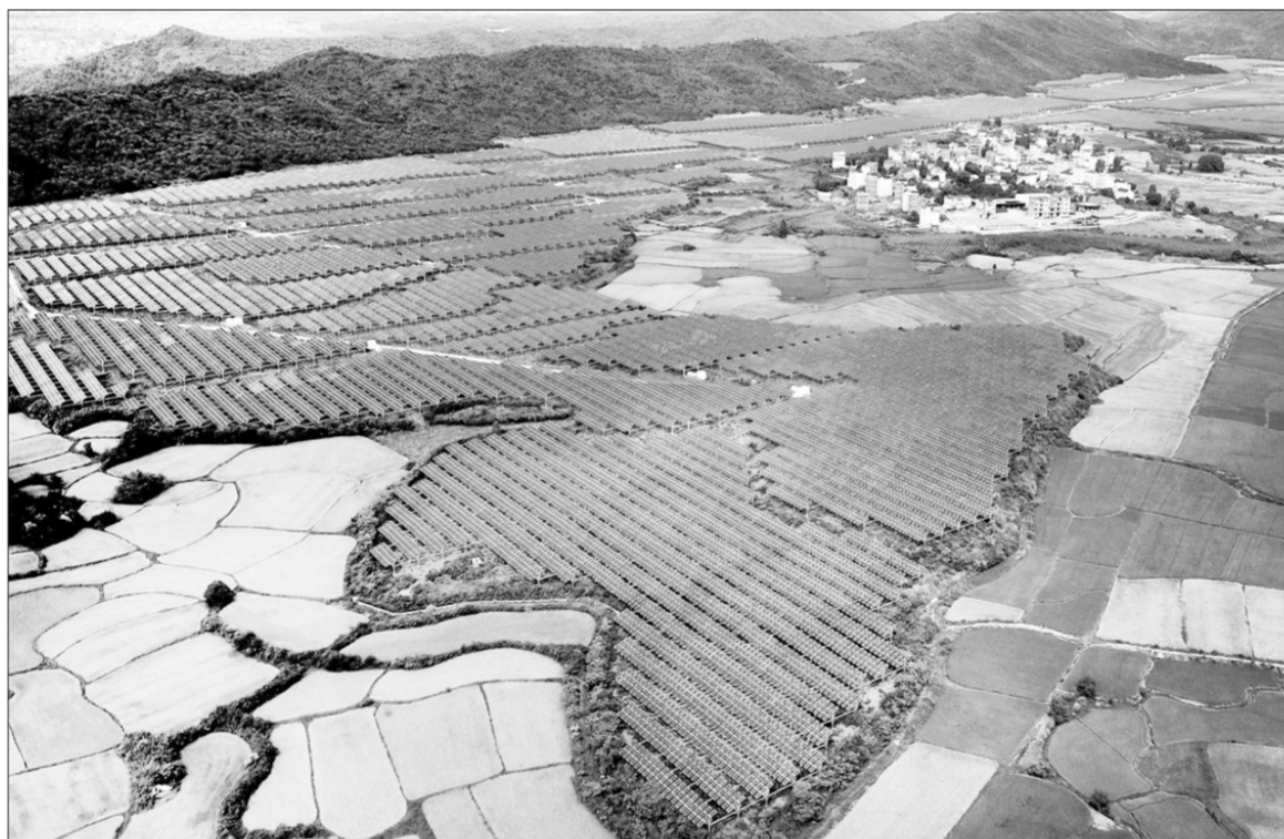
江西省乐平市 鹤鸣乡龙口村“国家电投江西乐平鹤鸣高家光伏电站”是乐平市农林互补光伏示范电站。电站全部采用双轴跟踪技术系统,在不改变土地性质的情况下,采用“以光促农、以光扶农、以光富农”的农光互补的电站模式,达到造福乡村、振兴乡村的目的。 人民图片网供图
