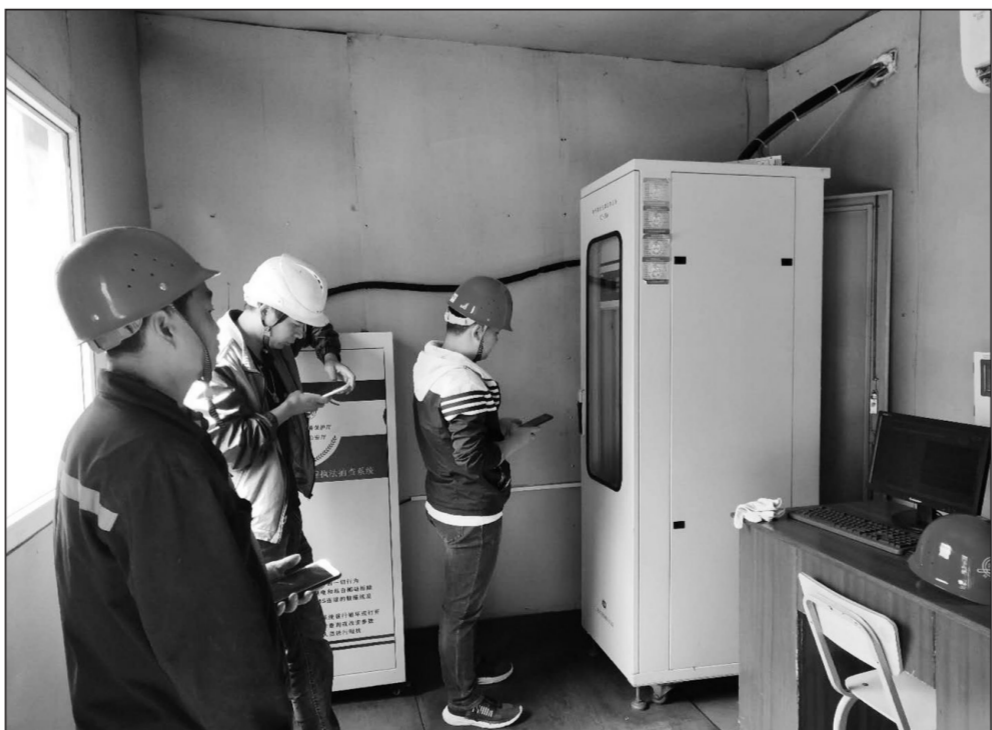
河北省环境综合执法局执法人员近日对辛集市澳森钢铁有限公司进行调研执法,重点对企业在在线监测设施运行台账及数据有效性进行核查,利用标准气体对设备进行全程标定和分析仪器标定。图为执法人员对企业在在线监测设施进行详细核查。
