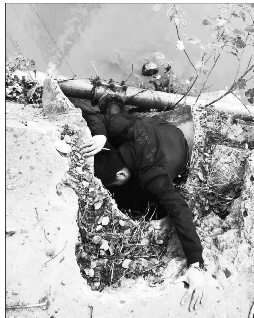
时间:2018年10月25日10:28 地点:安徽省安庆市谷桥大沟
