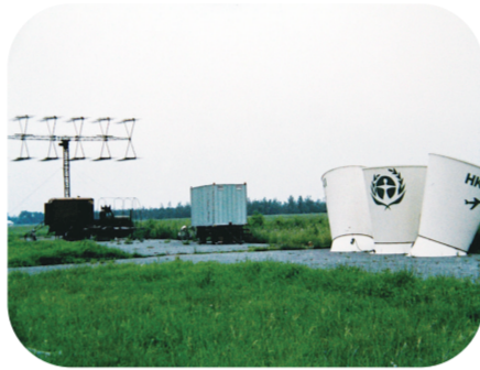
1988年,环科院自行研制成功HK-11型多普勒声雷达用于大气探测,3个大桶是雷达的天线,蓝色的是工作车。
