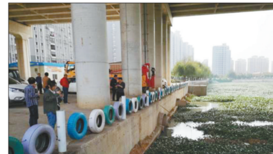
后官湖四环高架桥下的两个排污口。
