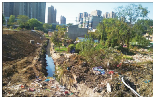
淮南铁路路边沟现场情况。
