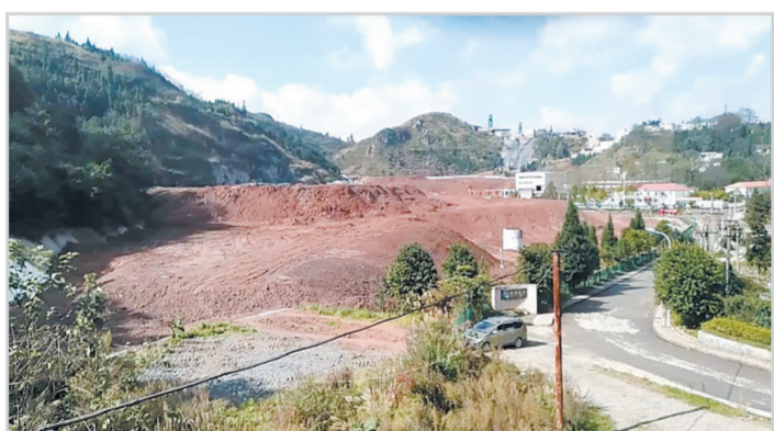
尾矿渣全部为露天堆放,无防扬尘、防雨淋措施。
