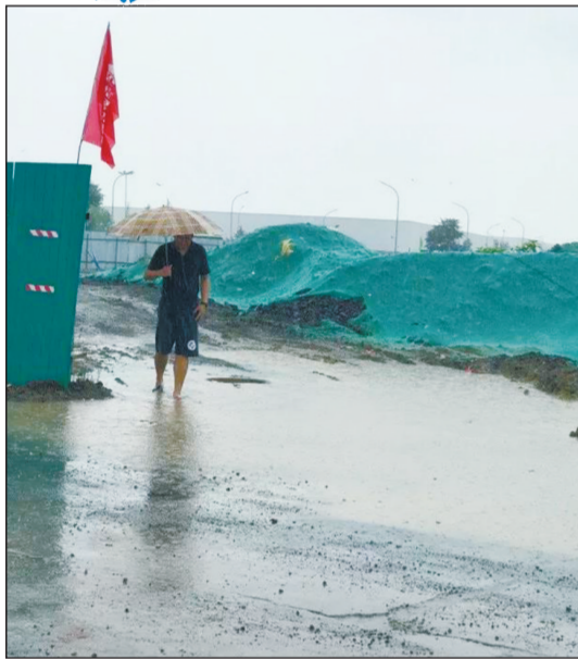
时间:2018年7月17日 地点:北京市房山区窦店镇市政施工工地
