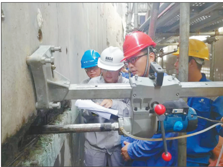
时间:2018年8月3日14:00 地点:广西壮族自治区防城港核电站
