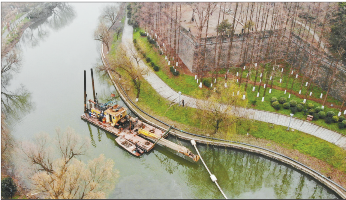
湖北省荆州市自2017年底启动了古城护城河及古城内湖泊疏浚清淤工程,与之配套的工程还有人工湿地及生态驳岸建设。近日,荆州市护城河水环境综合整治注重避免古城内的生活污水直排护城河,从源头上改善护城河水质问题,实现环荆州古城湿地“河畅、水清、岸绿、景美”的治理目标。
