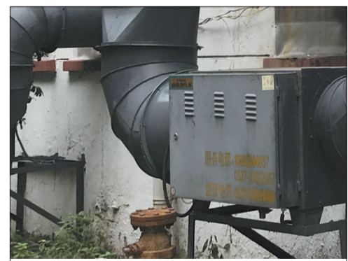
2018年,江苏省宿迁市创新餐饮油烟治理运维模式,在国内率先推出EPC(设计、施工、运行维护一体化)与BOT(建设、运营维护)一体化模式。经过一年的治理,全市餐饮油烟排放达标,广大商户安心经营,周边群众投诉大幅下降。据了解,这一模式已在宿迁市下辖其他区县推广。图为宿迁市楚街民间大灶台外安装的餐饮油烟治理设施。 韩东良 张爱松 徐万宁供图
